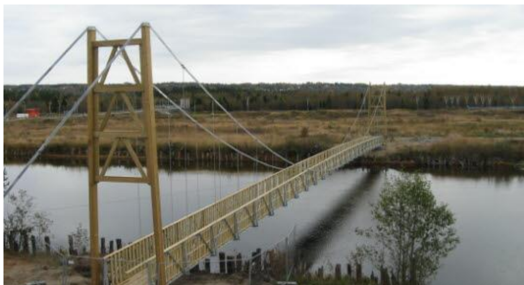
Hängbron över älvfåran vid Deltat. Bron är en hybridkonstruktion och invigdes 2015.
